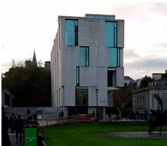
Figur 4 - Long Room Hub på Trinity College Dublin. Foto: Patrik Svensson
